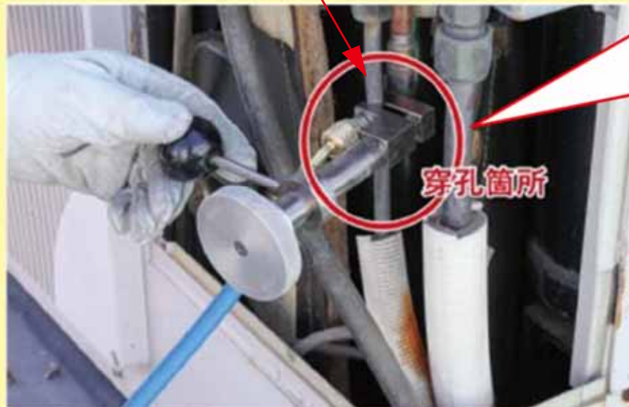
室外機の配管に穿孔している様子
